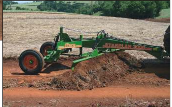
Recuperação de estradas vicinais.
